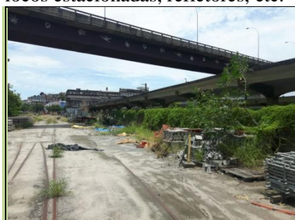
Acima, pátio interno da estação, sob o Viaduto da Linha Vermelha. Foto: A.D., internet.
